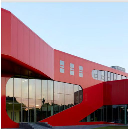
L' **ALLUMINIO COMPOSITO** è un pannello decorativo costituito da due lamine di alluminio che racchiudono un nucleo in polietilene. Grazie alle ottime proprietà del materiale è possibile realizzare soluzioni innovative in tutti i campi dell'architettura. Su richiesta certificazione A1.
